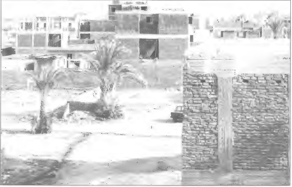
صورة (19): غياب بياض المحارة للحوائط الخارجية (تصوير د. جليلة القاضي)
